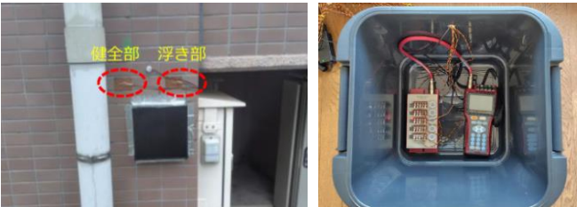
図1 測定機器（左：熱電対等、右：歪みロガー）
