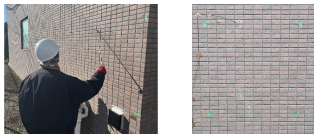
図 2 外壁タイル打診の様子
