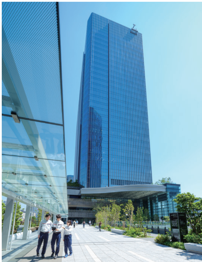
広大な街を定期的に巡回。背後にそびえるのは、この春オープンした「THE LINKPILLAR 2」
