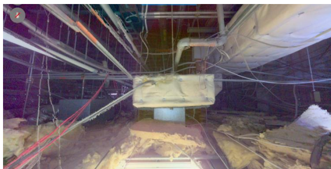
図5-1 3次元レーザースキャナーで点群データと同時に撮影した天井裏写真
