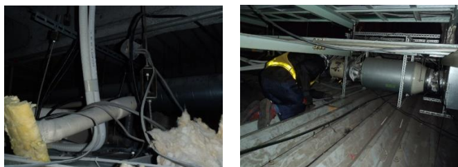
図1 駅天井裏狭隘部と現地調査の様子
