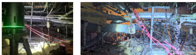
図3 測定状況（左）と取得した点群データ（右）
