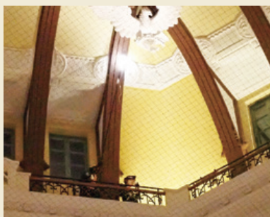
ドーム内側の漆喰飾りの状態を見るためライトをつけたウェアラブルカメラで確認
