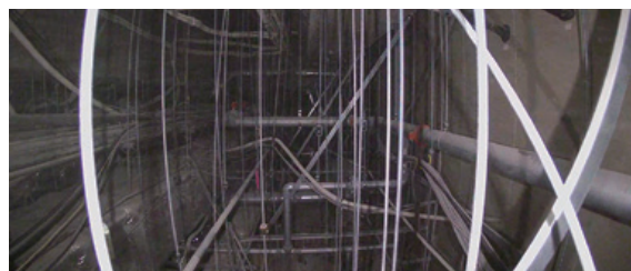
ドローン操縦の国家資格を持つ社員が小型ドローンを飛行させ、天井裏の実態を把握
