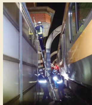
夜間に線路を閉鎖し、線路側の外壁もチェック
