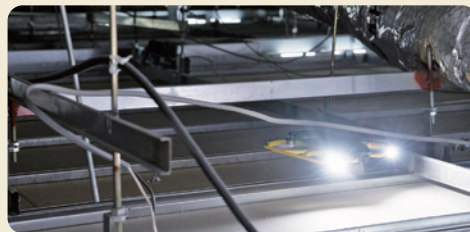
ドローンによる天井内調査
