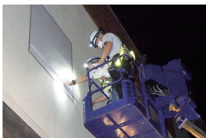
高所作業車を使った外壁調査
