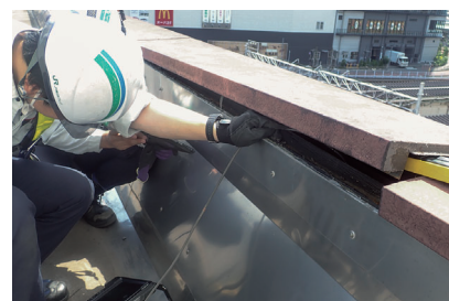
外壁上部パラペット部分の特殊検査機器（ファイバースコープ）による劣化状況調査
