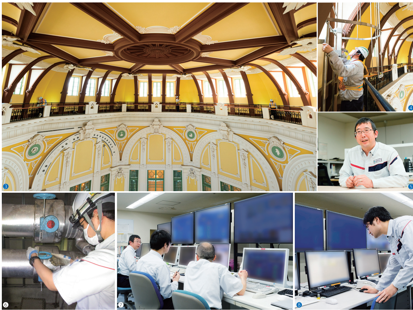
①東京駅丸の内駅舎の外壁を調査。見て、触って、予兆を検知します ②③④東京駅丸の内南口改札のコンコース。ドームの劣化状態も定期的に調査 ⑤東京支店 東京駅設備管理センター 三橋副所長 ⑥⑦⑧日々の業務で得られるデータと気づきが提案の種に（東京駅設備管理センターにて）
